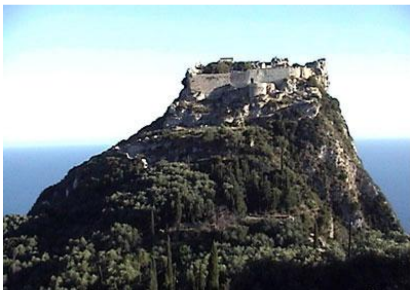
Εικόνα 4: Κάστρο Αγγελόκαστρο. Χτίστηκε υπό την εξουσία του Δεσπότη της Ηπείρου Μιχαήλ Άγγελου Κομνηνού.
