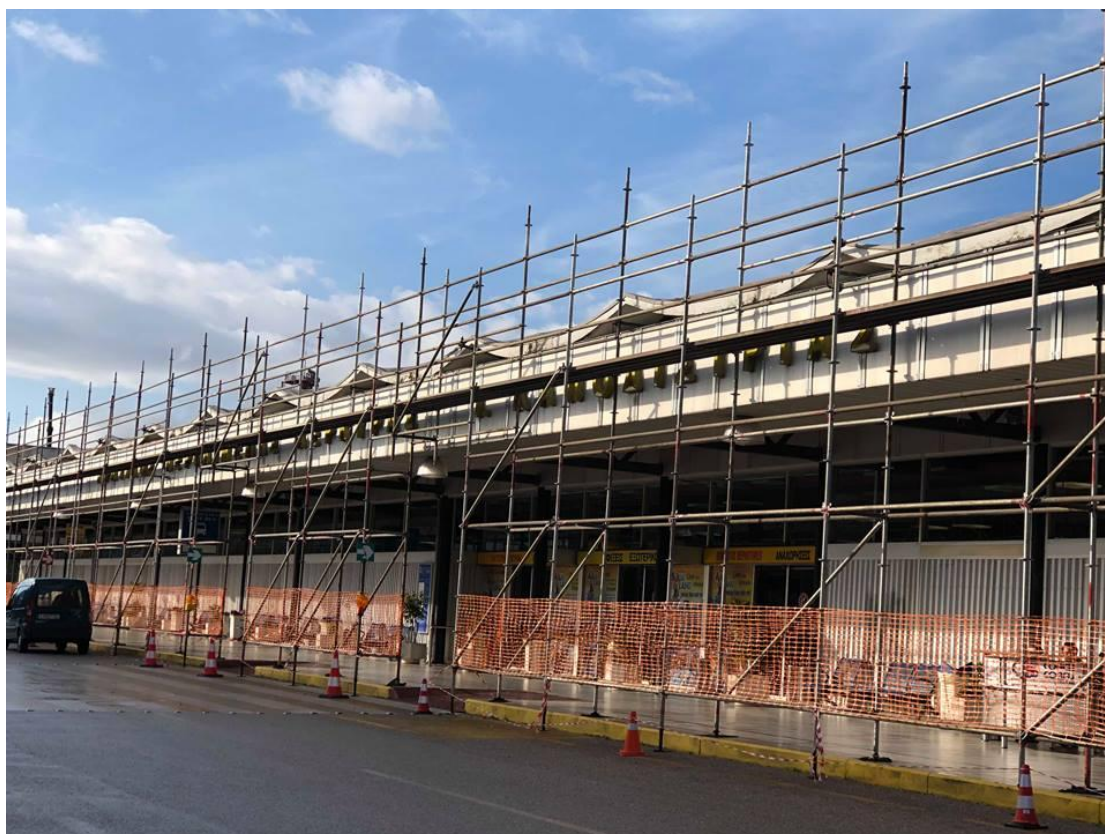
Εικόνα 20:Επισκευή του επιβατικού σταθμού του αεροδρομίου της Κέρκυρας υπό τον έλεγχο της Fraport.Κέρκυρα 2018
