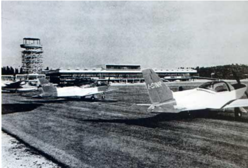
Εικόνα 10:Η ΚΑΤΑΣΚΕΥΗ ΤΟΥ ΠΥΡΓΟΥ ΕΛΕΓΧΟΥ ΣΤΟ ΑΕΡΟΛΙΜΕΝΑ ΤΗΣ ΚΕΡΚΥΡΑΣ ΤΟ 1972
