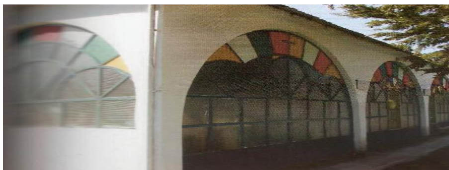
Εικόνα 30. Εξωτερική άποψη του ναού, λεπτομέρεια
