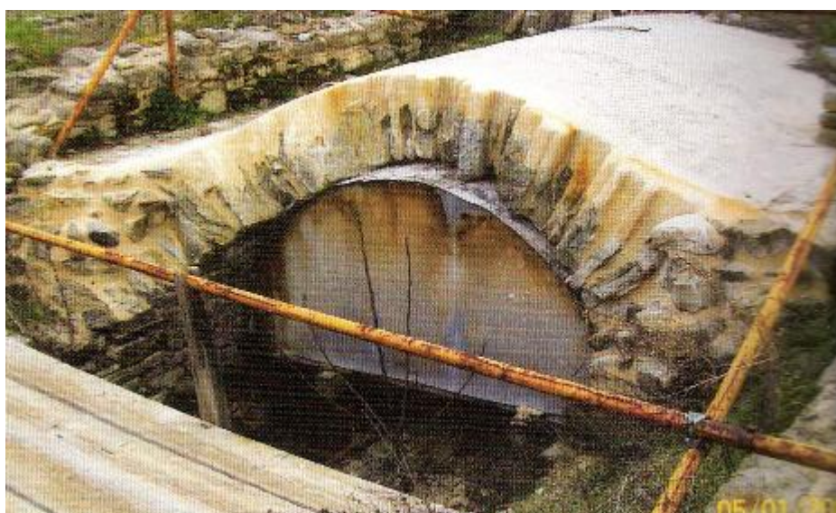
Εικόνα 7. Υπόγεια στέρνα (δεξαμενή νερού) στο εσωτερικό του φρουρίου
