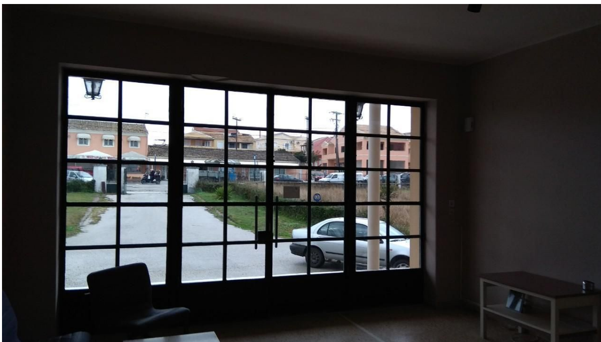
Εικόνα 8: “Είσοδος σταθμού. Εξασφαλίζει φυσικό φωτισμό”
