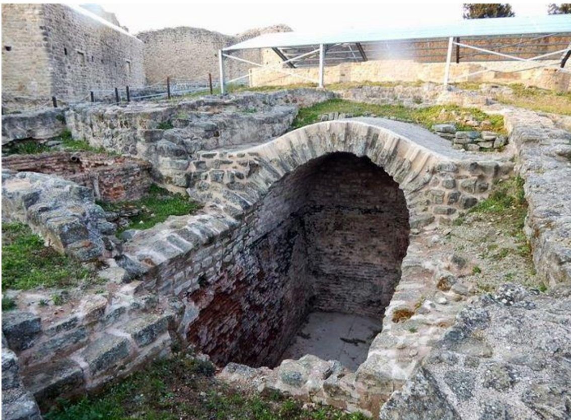
Εικόνα 19: Υπόγεια δεξαμενή στο εσωτερικό του κάστρου.
