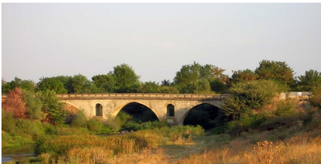
Εικόνα 31: Εμπρόσθια απόψη του γεφυριού.
