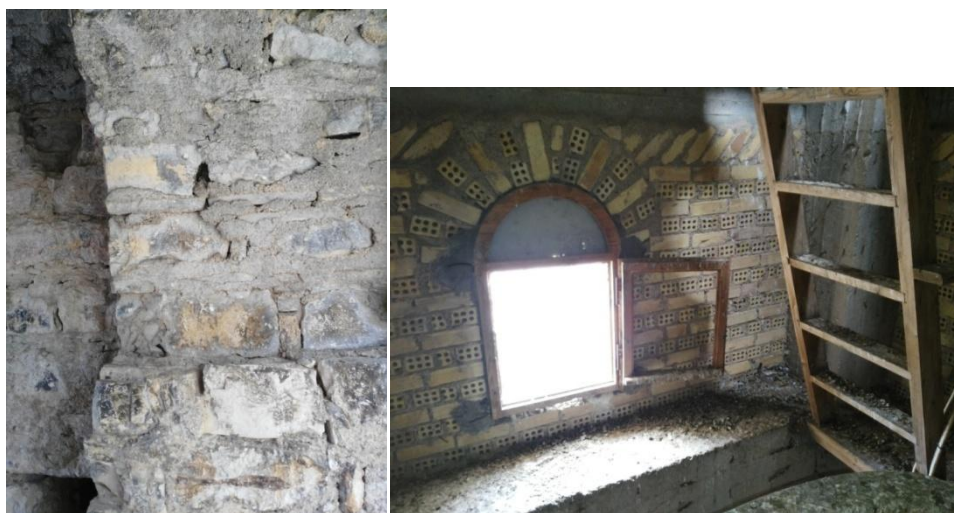
Εικ. 52. Εσωτερικό του καμπαναριού, αρχικά με πέτρα και στη συνέχεια με τούβλα (προς. αρχείο)
