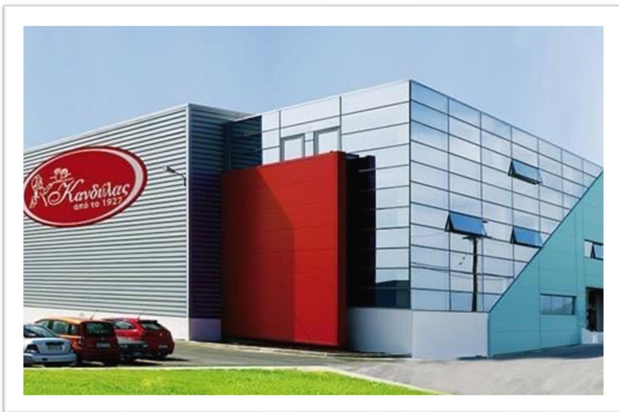
Εικόνα 7 .Οι νέες εγκαταστάσεις.
