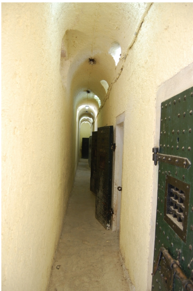
Εικόνα 13: Διάδρομος πειθαρχικών κελιών (πηγή: Χάρις Καββαδία)
