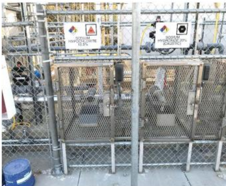
Εικόνα 11: Διαχωρισμός συνδέσεων εκφόρτωσης με ασφαλισμένο συρματοπλέγμα γύρω από τα σημεία σύνδεσης στη περιοχή Mod B (Πηγή:MGPI)
