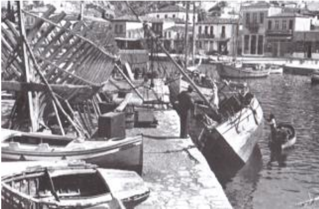
Εικ. 1: Ξύλινο σκάφος “τροπίζεται” για την συντήρηση των υφάλων του (Ύδρα 1948).
