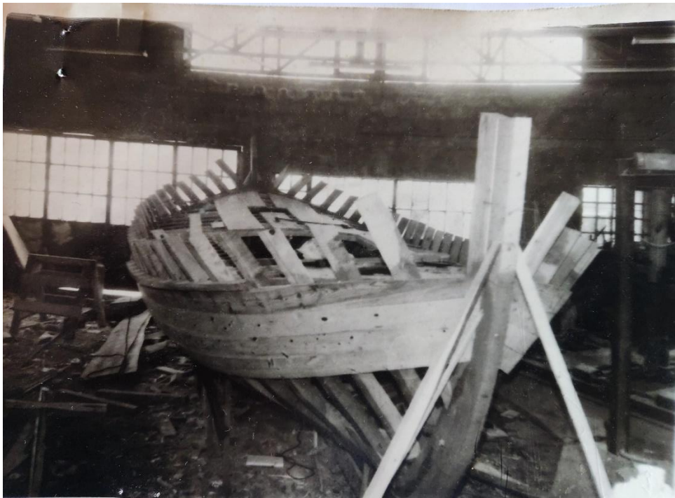
Εικ. 7: Σκελετός ξύλινου αλιευτικού. Ναυπήγημα ΠΑΠΑΔΑΤΟΥ Σωτήριου (Κέρκυρα, 1987)
