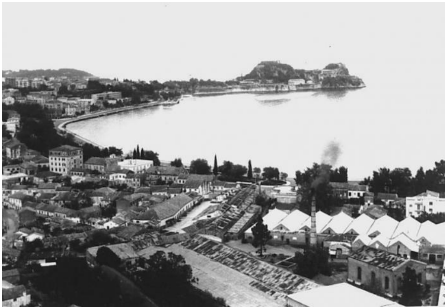
Εικόνα 9: Εργοστάσιο Δεσύλλα. Πηγή Στούπης, 2018
