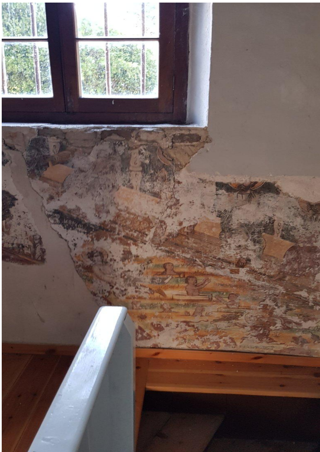
Γυναικωνίτη. Δυτικός τοίχος. Σκηνές κολάσεως
