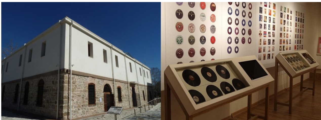
Εικόνα 15, Εικόνα 16: Άποψη του κτηρίου που σήμερα στεγάζει το Κέντρο Έρευνας – Μουσείο Τσιτσάνη και από το εσωτερικό του, με τις προθήκες, το πληροφοριακό υλικό και τις νέες τεχνολογίες. Πηγή: https://trikalacity.gr (τελευταία ημερομηνία προσπέλασης: 1/11/18).
