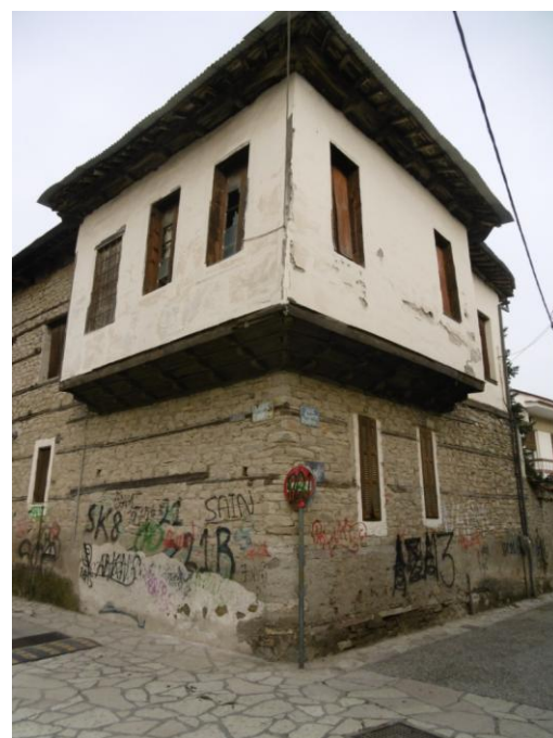
Εικόνα 17: Εξωτερική άποψη του Αρχοντικού Κυρνάσιου, στη κατάσταση που είναι σήμερα. Πηγή: Προσωπικό Αρχείο.
