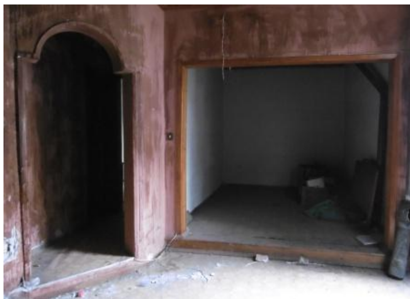
Εικόνα 30: Άποψη του ισόγειου χώρου, διακρίνονται: α. τα καλλωπιστικά αρχιτεκτονικά στοιχεία του χώρου και β. το βάθος και τα δύο επίπεδα του χώρου. Πηγή: Προσωπικό Αρχείο.
