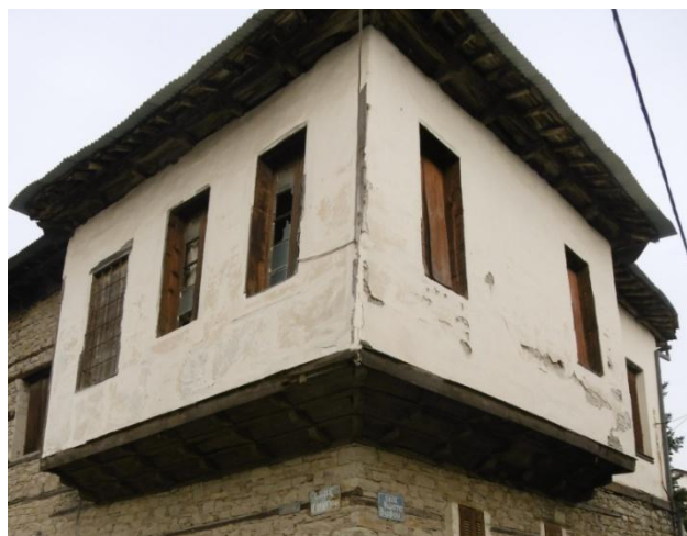
Εικόνα 18: Το σαχνισί ή σαχνισιά του Αρχοντικού Κυρνάσιου, ορολογία της αρχιτεκτονικής, η οποία αναφέρεται στις προεξοχές παραδοσιακών κτηρίων, και περιγράφει προεξοχές στηριγμένες σε ξύλινα δοκάρια οι οποίες βρίσκονται πέρα από τα όρια της τοιχοποιίας του ισόγειου. Πηγή: Προσωπικό Αρχείο.
