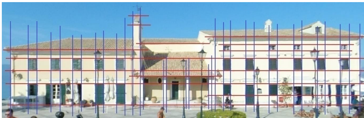
Εικόνα 3.2: Άποψη του κτηρίου από τα νότια με οριζόντιες και κατακόρυφες χαράξεις.
