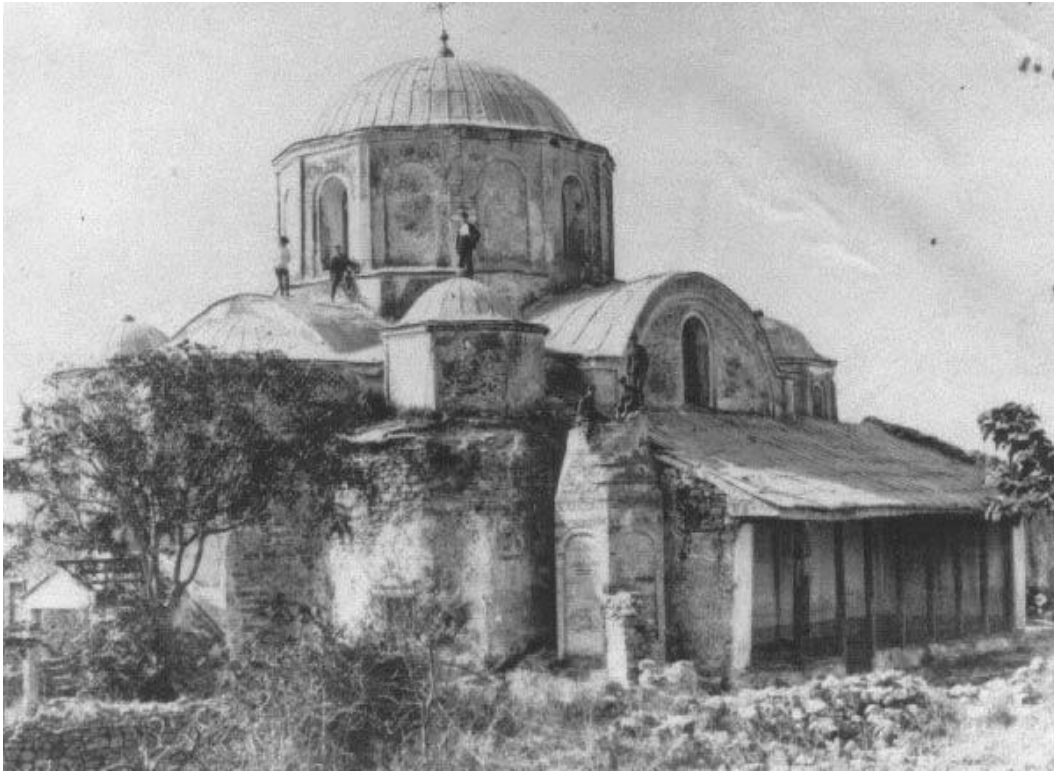
Εικόνα 3 Εργασίες αποκατάστασης της μονής
