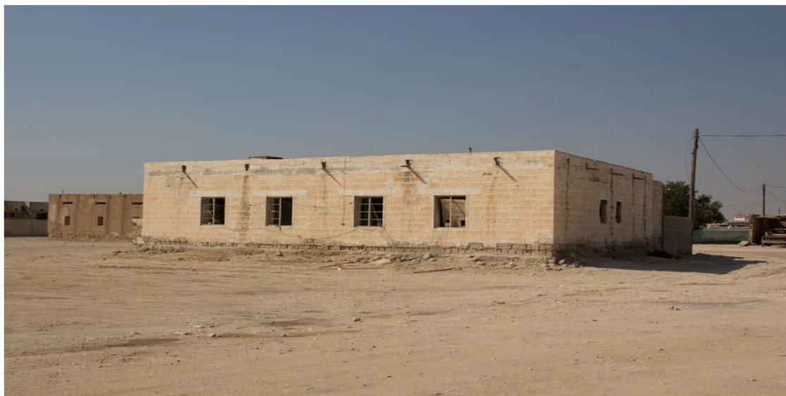
Εικόνα 35: Το Building 6 με βόρειο προσανατολισμό.
