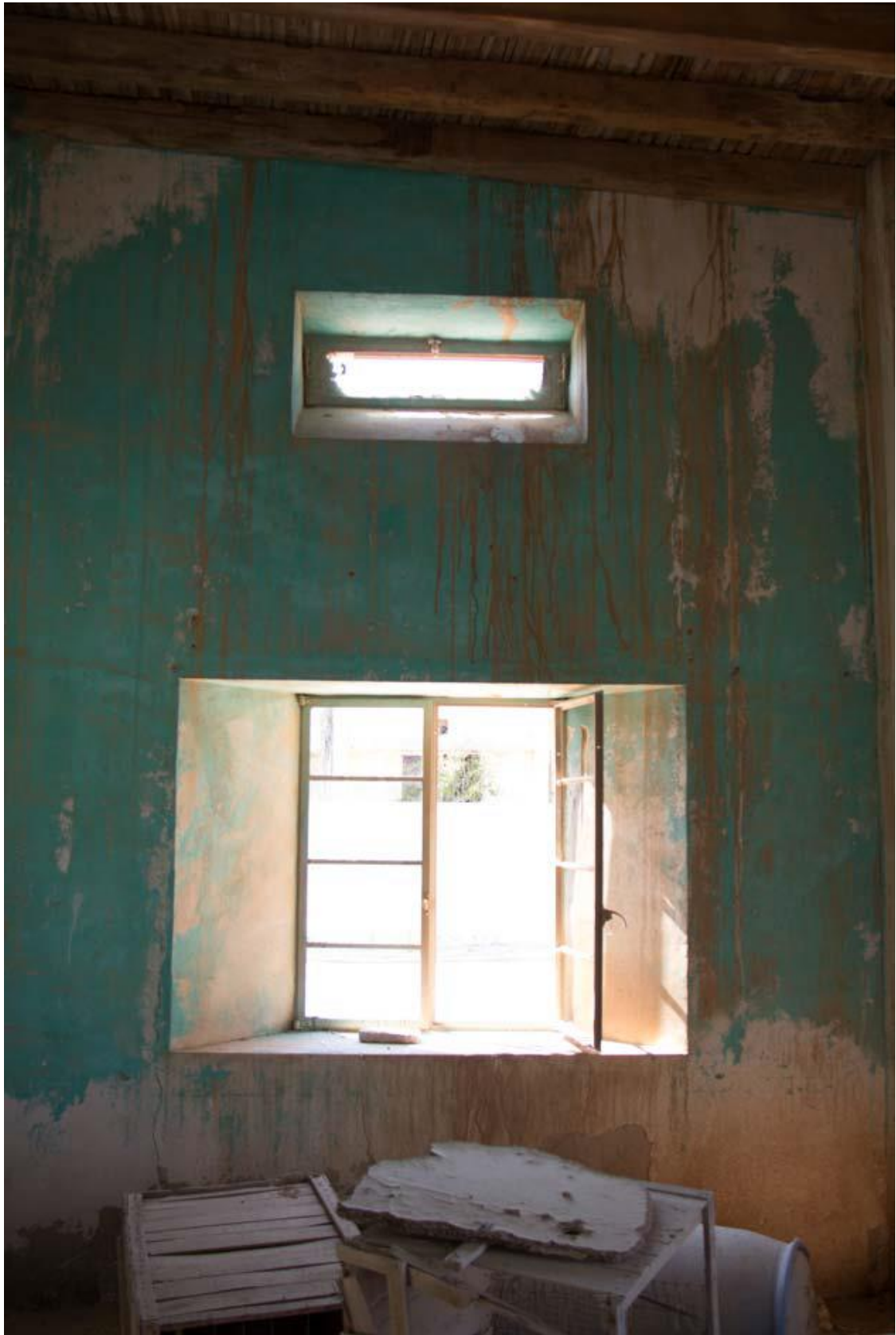
Εικόνα 19: Φωτογραφία των παραθύρων και των αεραγωγών του Building 3.
