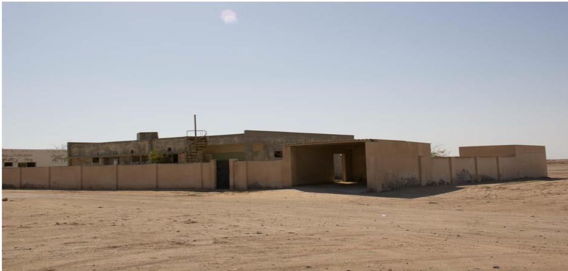
Εικόνα 29: Το Building 5 με νοτιοδυτικό προσανατολισμό.
