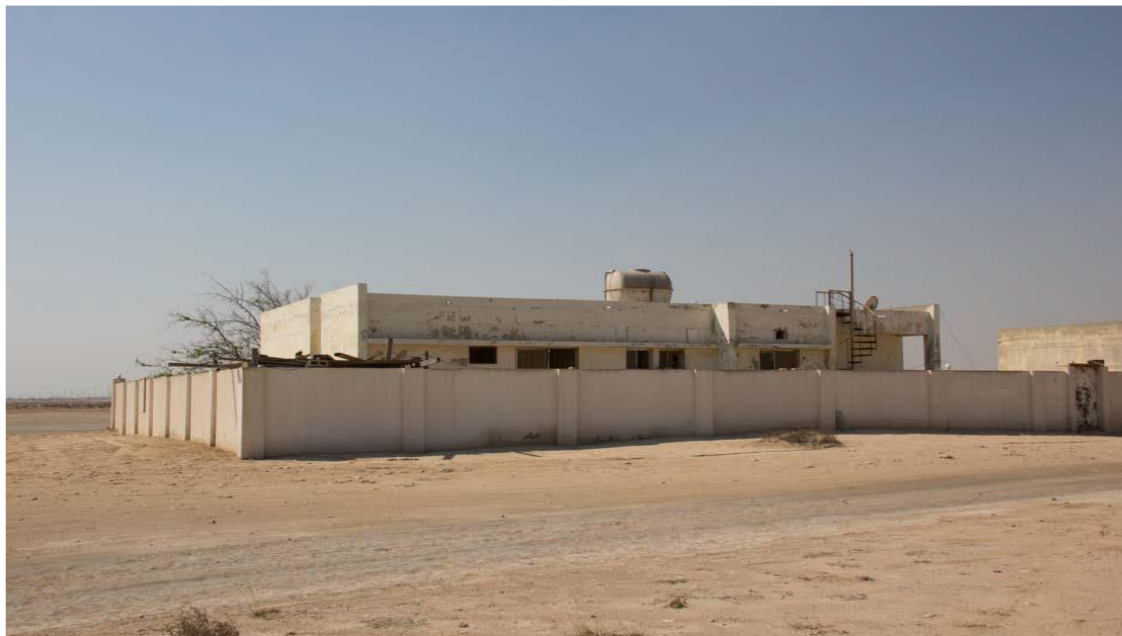
Εικόνα 25: Το Building 4 με βόρειο προσανατολισμό.
