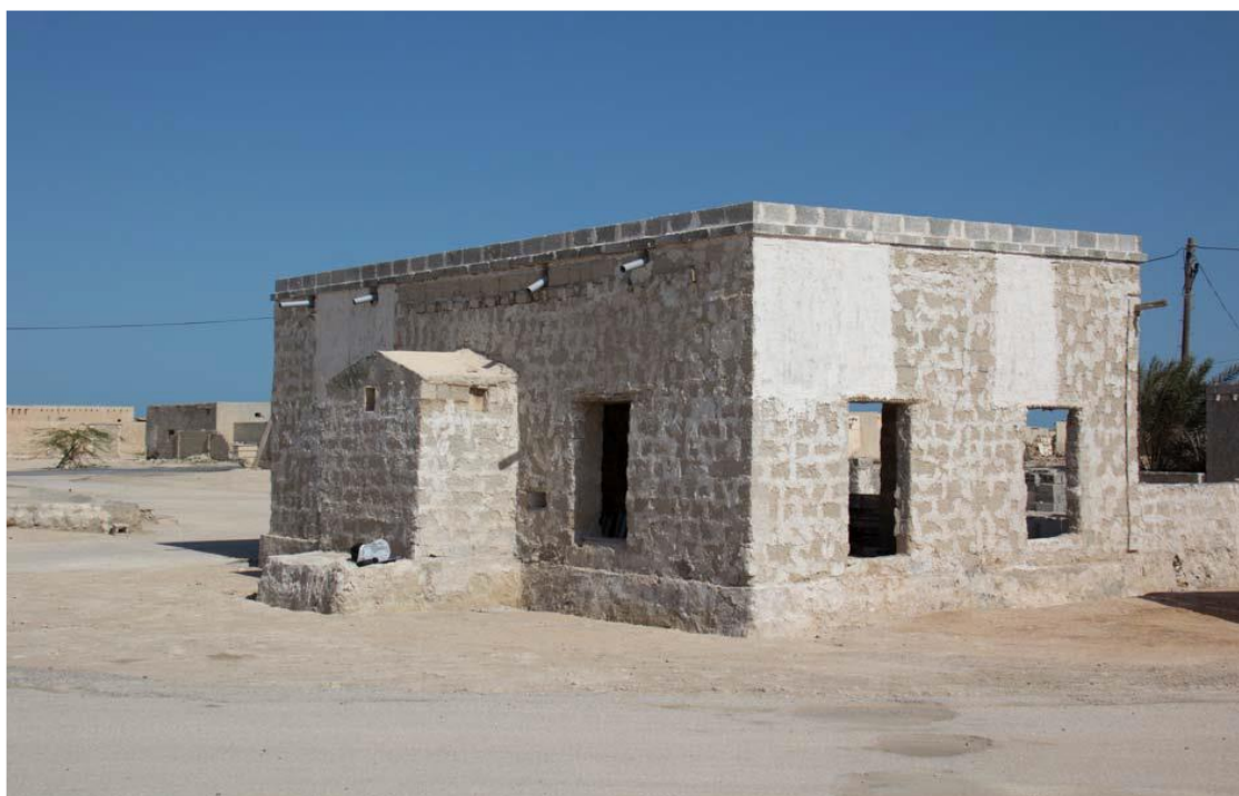
Εικόνα 12: Το Building 2 με βόρειο προσανατολισμό, όπου βρίσκεται υπό ανακατασκευή.
