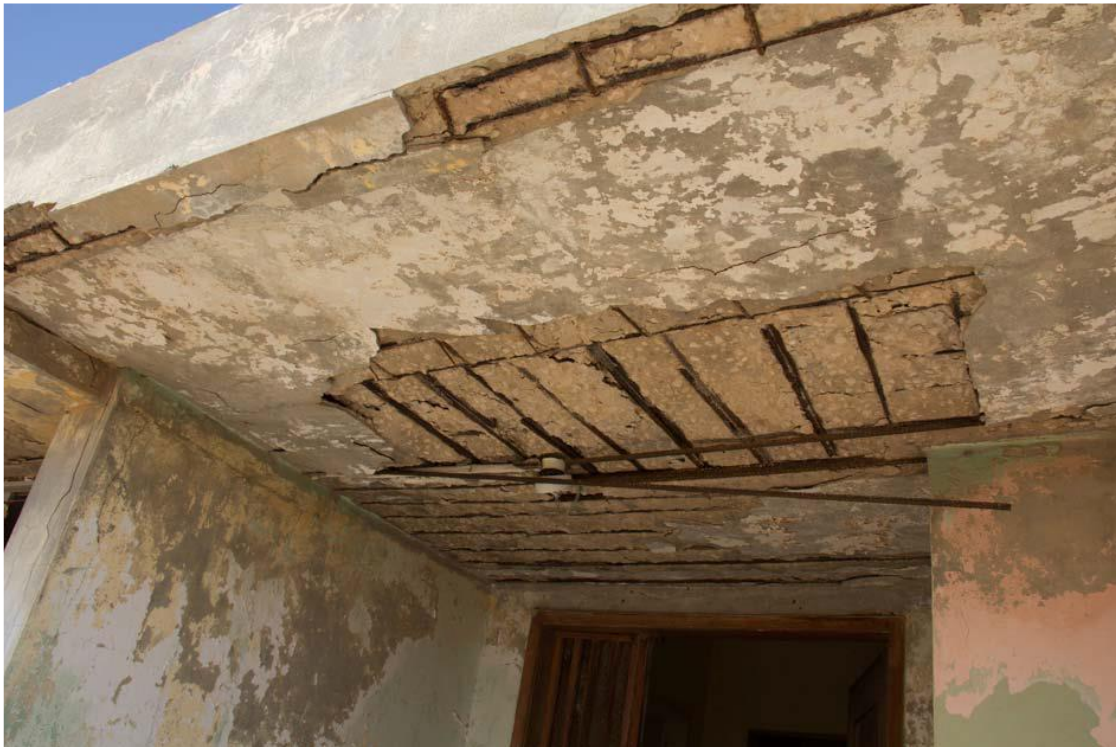
Εικόνα 30: Φωτογραφία της κατασκευής της σκεπής του Building 5.
