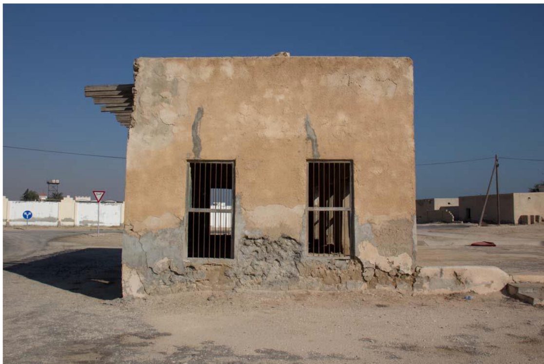
Εικόνα 6: Το Building 1 με βόρειο προσανατολισμό.
