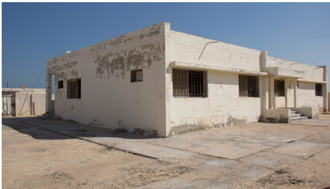
Εικόνα 22: Το Building 4 με νοτιοδυτικό προσανατολισμό.
