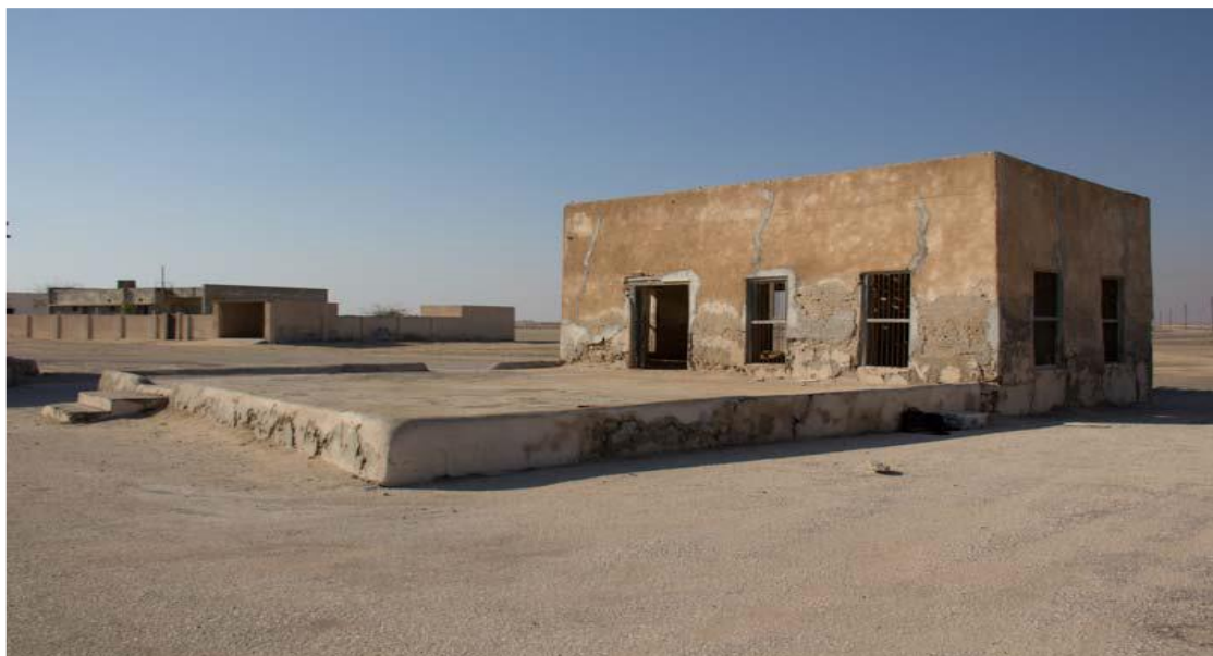
Εικόνα 4: Το Building 1 με νοτιοανατολικό προσανατολισμό.
