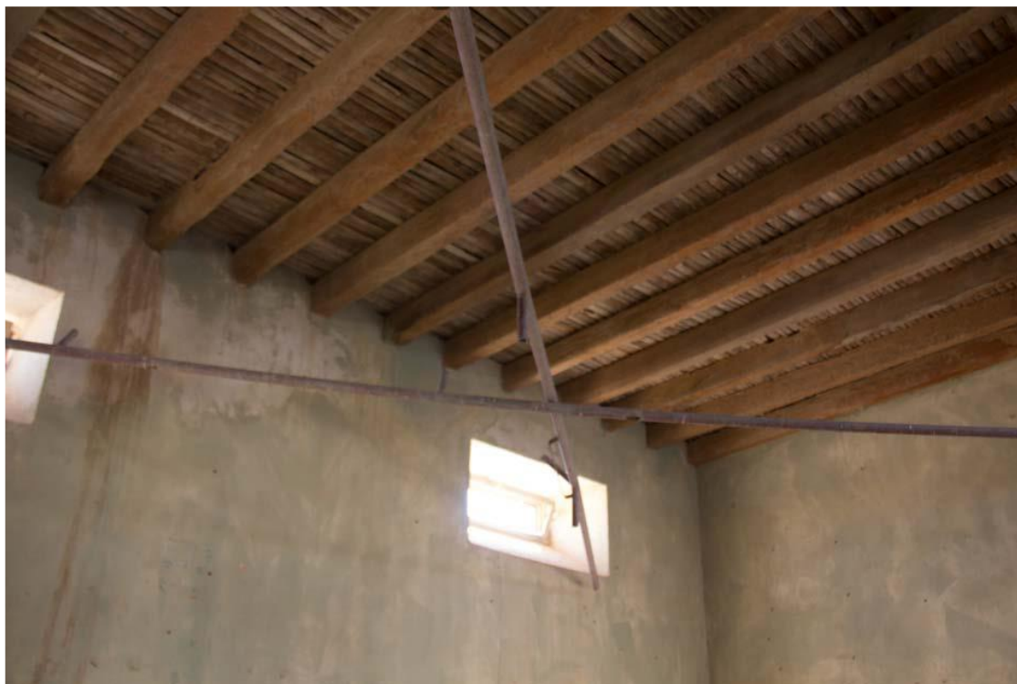
Εικόνα 20: Μεταβατική στέγη από το εσωτερικό του Building 3.
