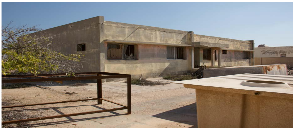
Εικόνα 27: Το Building 6 με νοτιοανατολικό προσανατολισμό.
