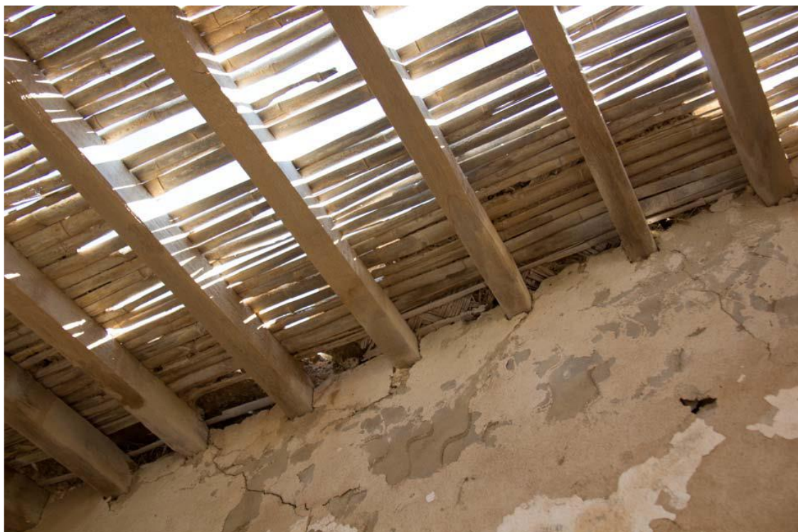
Εικόνα 9: Φωτογραφία της οροφής του Building 1.
