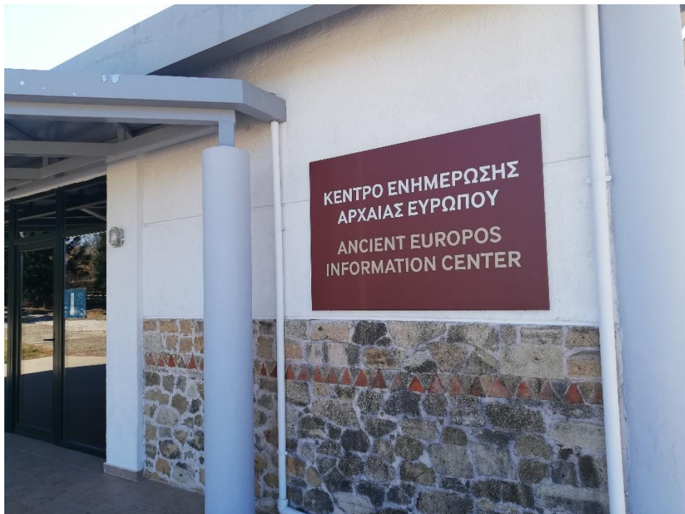
Εικ.07 Εξωτερικός χώρος Κέντρου Ενημέρωσης
