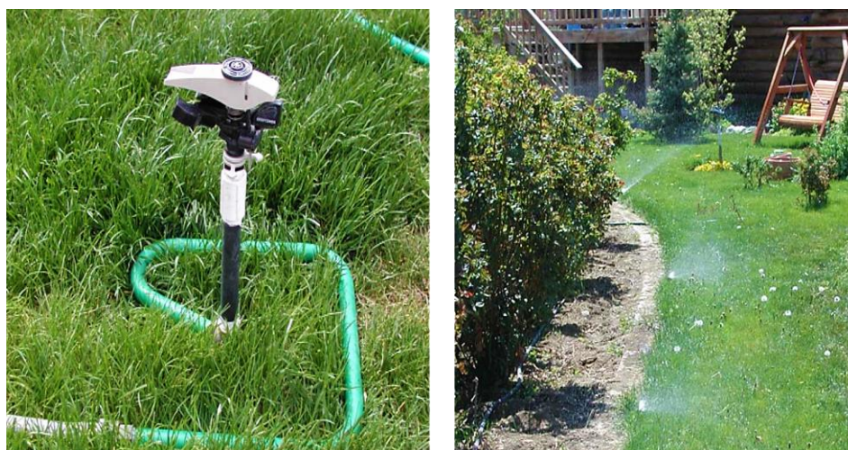
Εικόνα 15: Αριστερά : Φορητή κεφαλή ψεκαστήρα κρούσης συνδεδεμένη σε σωλήνα κήπου Δεξιά: Αναδυόμενες κεφαλές ψεκασμού μισού κύκλου που τροφοδοτούνται από έναν εύκαμπτο σωλήνα κάτω από την επιφάνεια. 29
