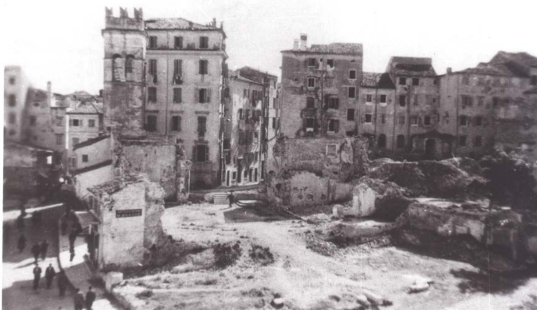
Εικόνα 7 Η Annunziata μετά την κατεδάφιση των ερειπίων της
