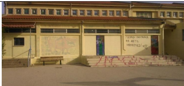
Εικ. 85: Μέρος επιλεγμένου χώρου στο προαύλιο του σχολείου.
