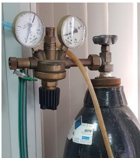
Εικόνα 11: Φιάλη αδρανούς αερίου.
