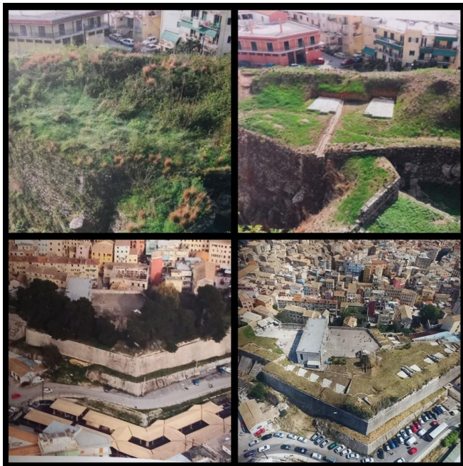
Εικόνα 9 Προμαχώνας Σαράντη και νότιο τμήμα Σκαρπώνα πριν και μετά τις εργασίες
