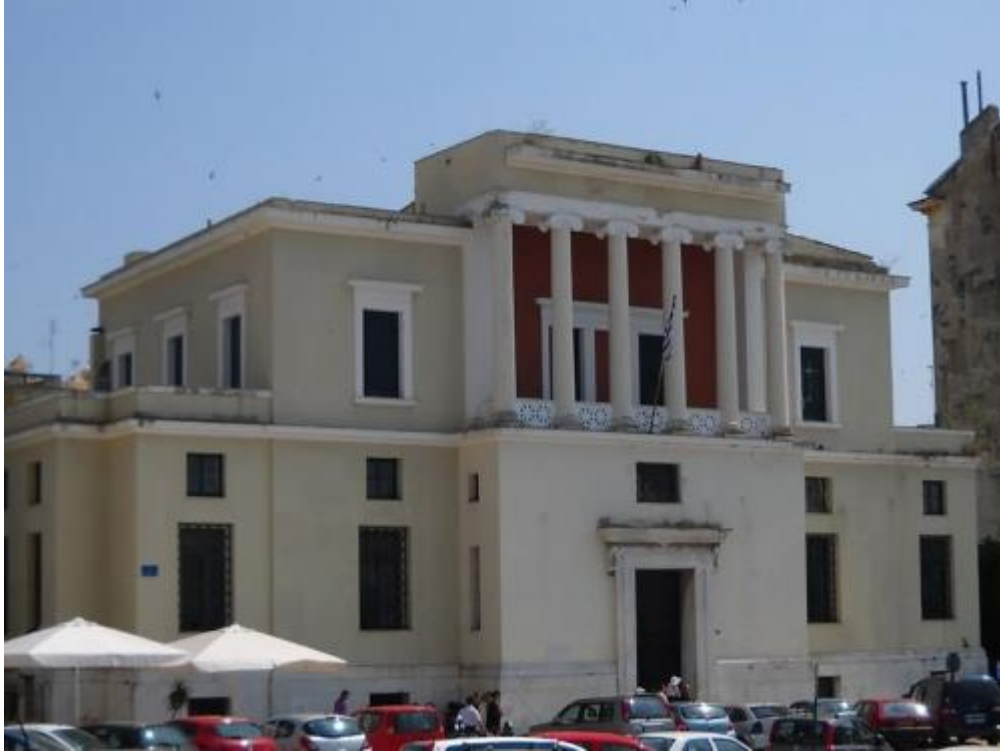
Εικόνα 2. Το κτήριο που στεγαζόταν το Εφετείο Κέρκυρας μέχρι το 2012
