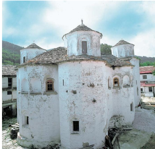
Εικόνα 19. Εξωτερική άποψη ναού
