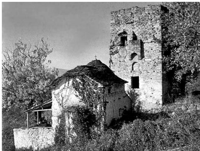
Εικόνα 30. Ερείπια πύργου Αγίου Λαυρεντίου
