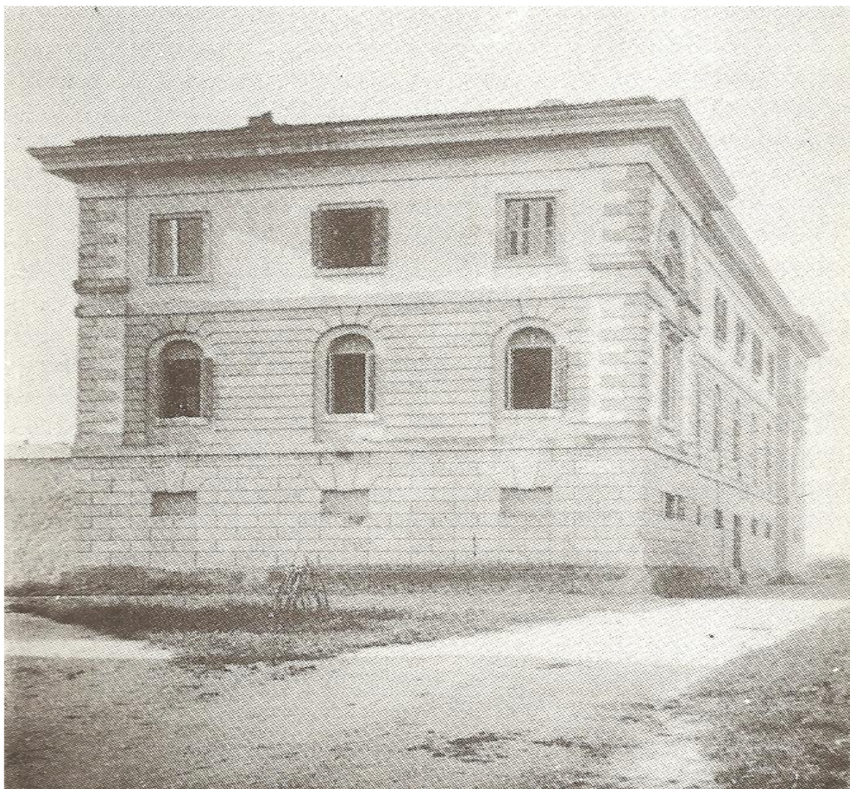
Εικ. 4: Το κτίριο του Αστικού Νοσοκομείου στην οδό Κολοκοτρώνη, όπως ήταν την περίοδο του Μεσοπολέμου 11
