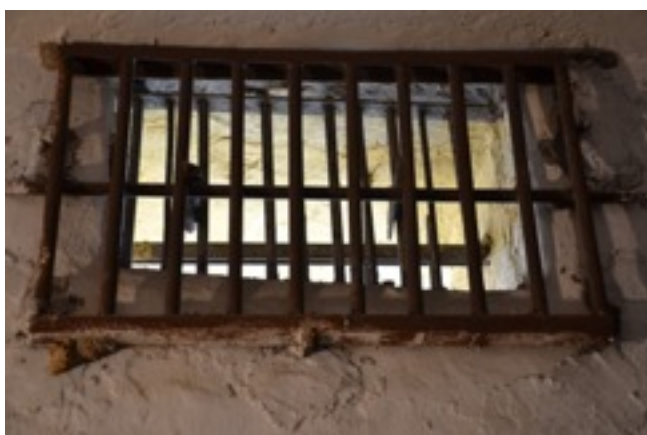
Εικόνα 53. Παράθυρο στο διάδρομο της Απομόνωσης.
