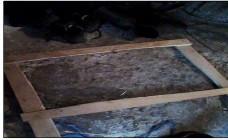
Εικόνα 16: Κατασκευή ξύλινου πλαισίου.
