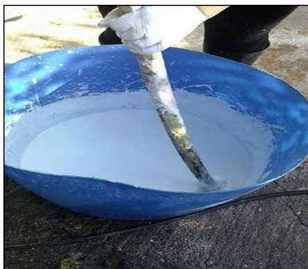
Εικόνα 10-11: Παρασκευή του ασβέστη για την τοποθέτηση του δέρματος.
