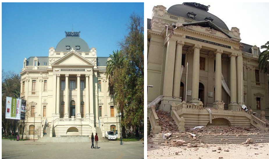
Εικόνα 17: Το κτίριο πριν και μετά το σεισμό του 2010 μεγέθους 8,8 ρίχτερ πηγή: http://www.montrealgazette.com/news/canada/Gazette+Twitter/1452132/Gallery+Massive+earthquake+Chile/2621667/story.html )
