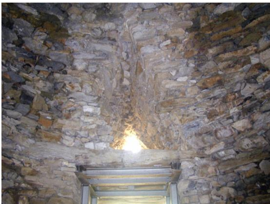
Εικόνα 15: Διμήνι. Άποψη της εισόδου με το ανακουφιστικό τρίγωνο (ΥΠΠΟΑ - ΕΦΑ Μαγνησίας)
