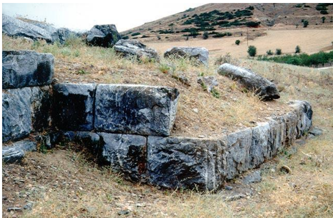
Εικόνα 6: Άποψη της οχύρωσης του 4ου αι. π.Χ., ακρόπολη Φερών (ΥΠΠΟΑ – ΕΦΑ Μαγνησίας)
