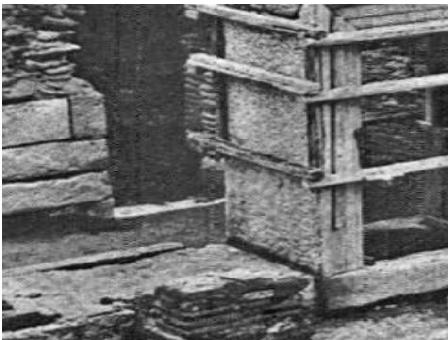
Εικόνα 17. Η προσωρινή στερέωση της μαρμάρινης θύρας του Ωδείου επί Α. Βαβρίτσα.
