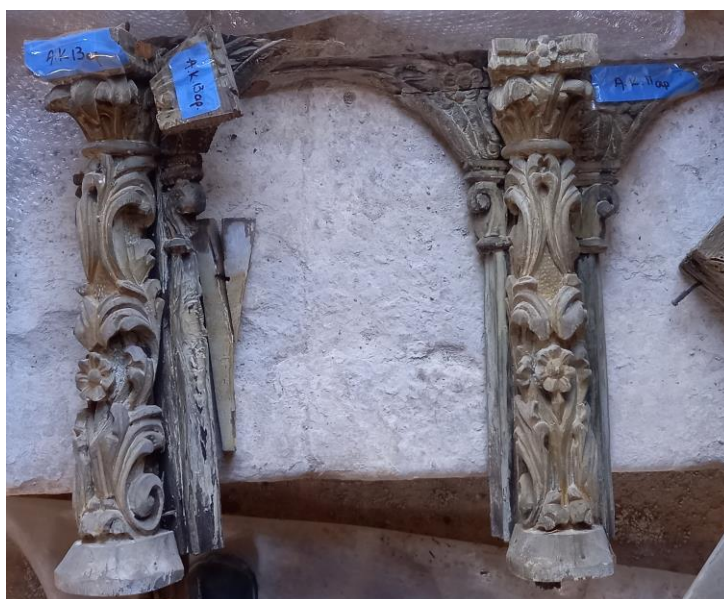
Εικόνα 39. Παράδειγμα προσθήκης κωδικών/αριθμών μέτρησης πριν την απόσπαση (Πηγή: Χρ. Καρύδης)
