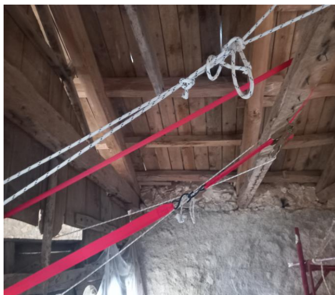
Εικόνα 41. Παράδειγμα στήριξης των τμημάτων της ανώτερης ζώνης με ιμάντες (Πηγή: Χρ. Καρύδης)
