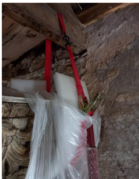
Εικόνα 40. Παράδειγμα προστασίας σημείων με ethafoam για την μεταφορά (Πηγή: Χρ. Καρύδης)
