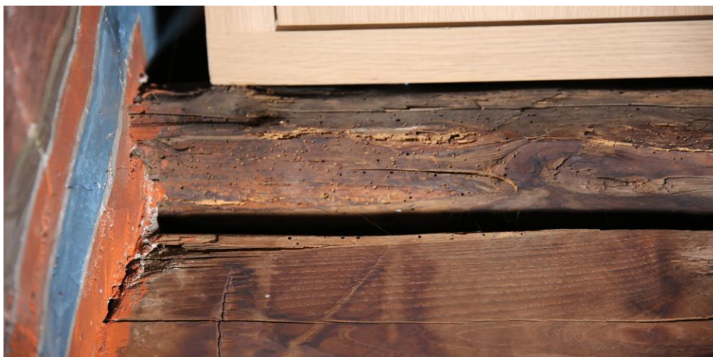
Εικόνα 35. Λεπτομέρεια από το σημείο ένωσης του κεντρικού δοκαριού με την τοιχοποιία. Τα ασβεστοκονιάματα, καθώς και η πορτοκαλί χρωστική υπάρχουν και στην επιφάνεια του ξύλου (Πηγή: Χρ. Καρύδης)
