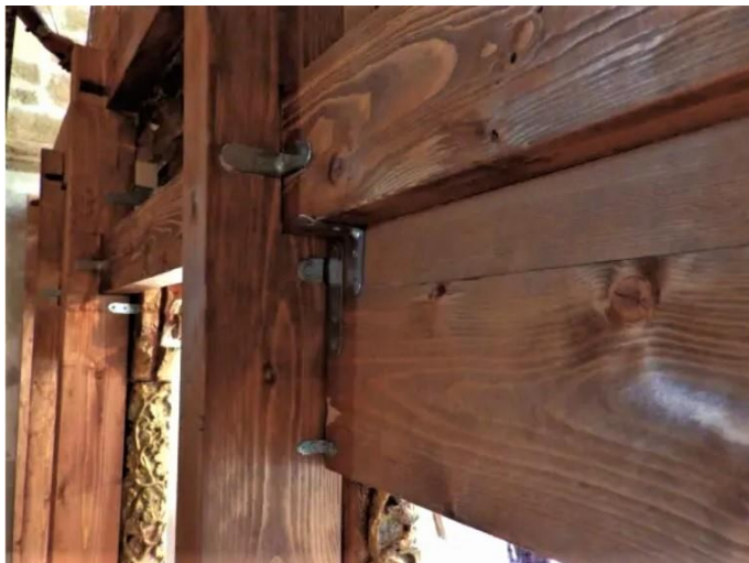
Εικόνα 42. Παράδειγμα σύνδεσης τμημάτων σε ξύλινο πλαίσιο (Πηγή: Π. Γερολυμάτου, σελ.24)
