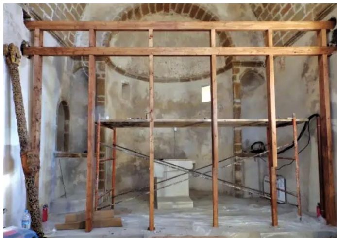
Εικόνα 45. Παράδειγμα ξύλινου πλαισίου στήριξης (Πηγή: Π. Γερολυμάτου, σελ.15)
