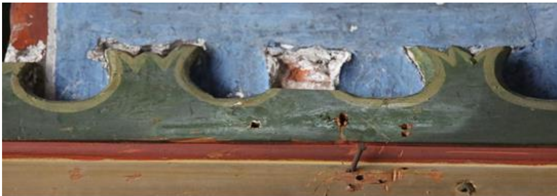
Εικόνα 25. Λεπτομέρεια απώλειας πρόσθετου ξυλόγλυπτου διακόσμου, ορατή η ένωση με την τοιχοποιία (Πηγή: Χρ. Καρύδης)
