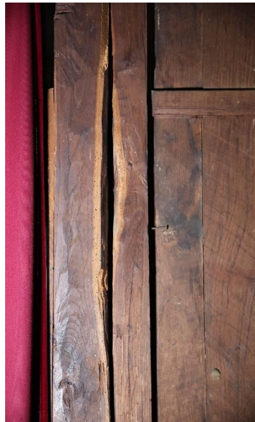
Εικόνα 33. Λεπτομέρεια από τα δοκάρια στήριξης. Υπάρχουν εκδορές, απώλεια υλικού, προσβολή από ξυλοφάγα και ένα καρφί άγνωστης χρηστικότητας (Πηγή: Χρ. Καρύδης)
