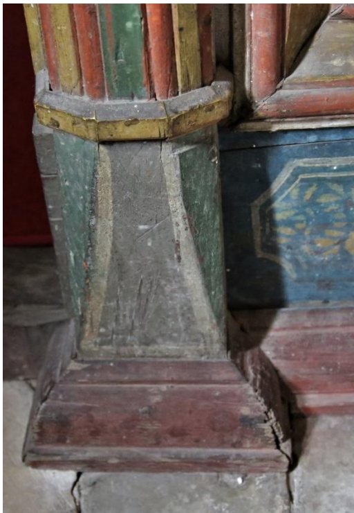
Εικόνα 36. Λεπτομέρεια από τον πεσίσκο στην βάση. Εκδορές και ρωγματώσεις, καθώς και απώλεια υλικού λόγω προσβολής από ξυλοφάγα είναι εμφανή (Πηγή: Χρ. Καρύδης)
